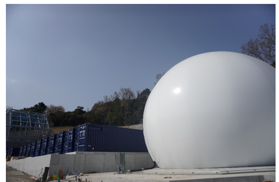
建設中のバイオガス発電所
